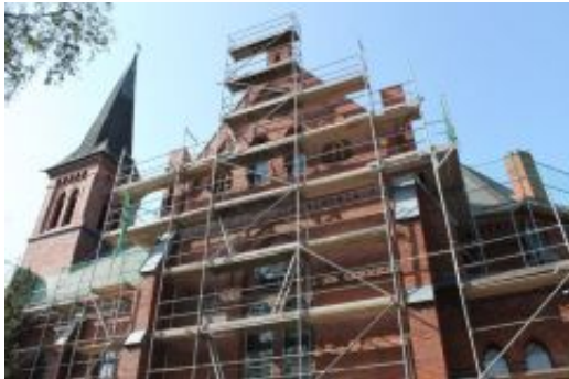
Dacharbeiten St. Joseph Sommer 2012
